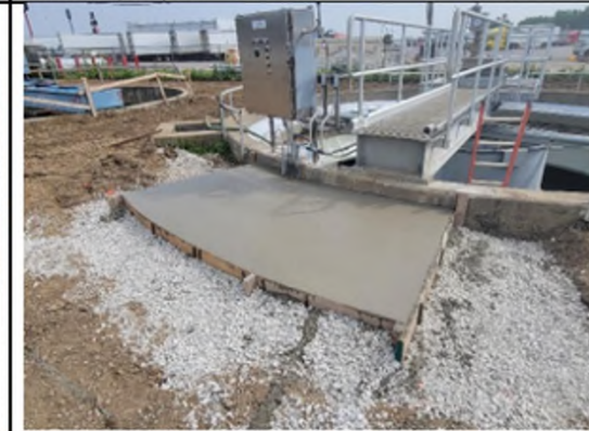
Concrete pad pour – CLARI #3
